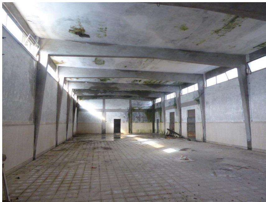
Fotografia n. 191 Piano terra. Vista della palestra.
